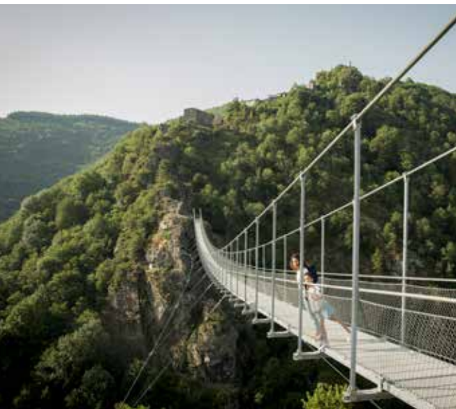
LA PASSERELLE de Mazamet
