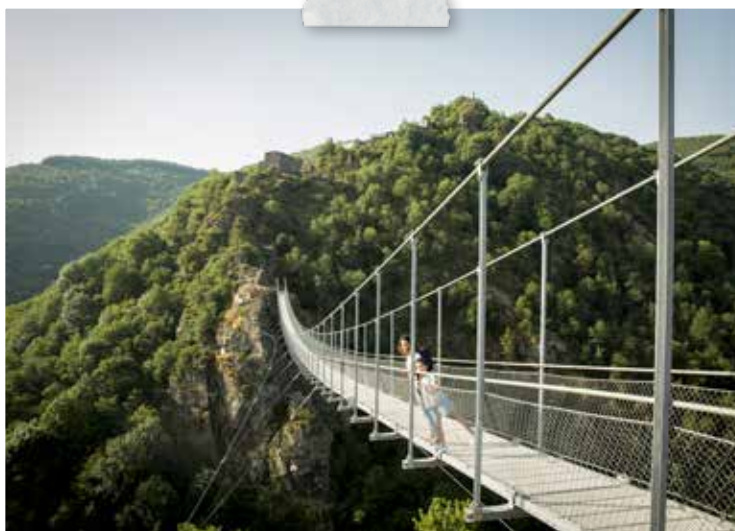
Passerelle de Mazamet
